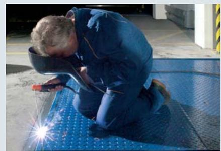
An die Randwinkel anschweißen – fertig!
