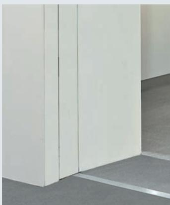
Nischenklappe bei geöffnetem Tor
